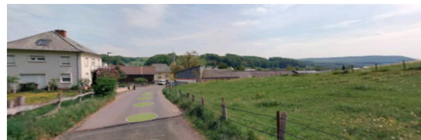
Illustrations 5: photos du site (source : sigcom cyclomedia Commune de Tandel)
