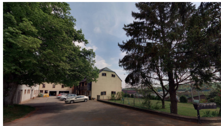
Dikricherstrooss vue sur les bâtiments existants au nord du site
